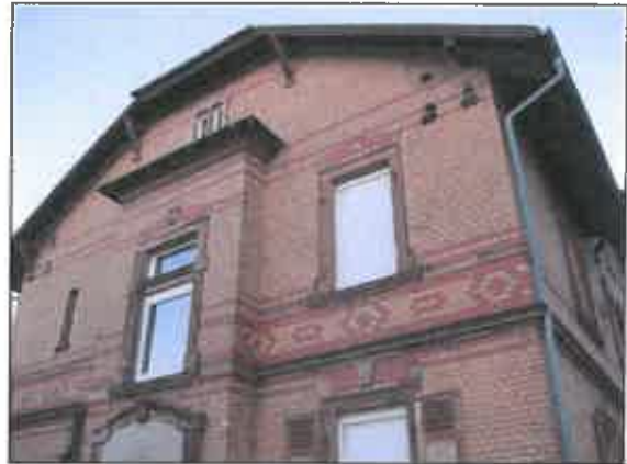
Abb. 2: Gebäude Eisenbahnstraße Nr. 14 u. 16 mit Einflüglern/Nischen im Dachbereich
