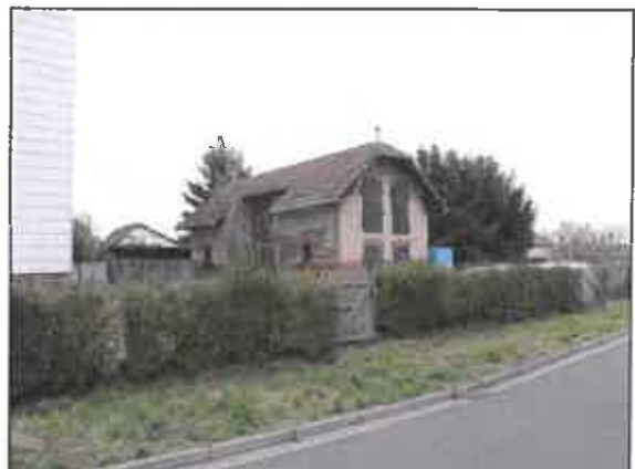
Abb. 4: Denkmalgeschütztes Gebäude im Süden
