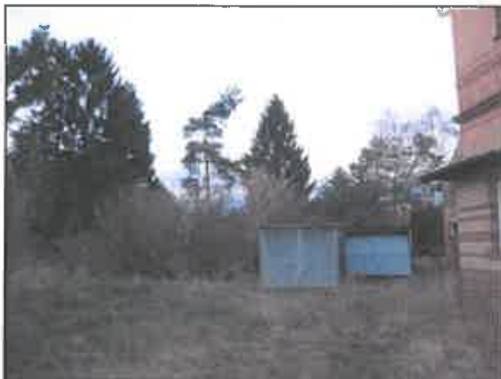
Abb. 3: Gartenbereich Haus Nr. 14
