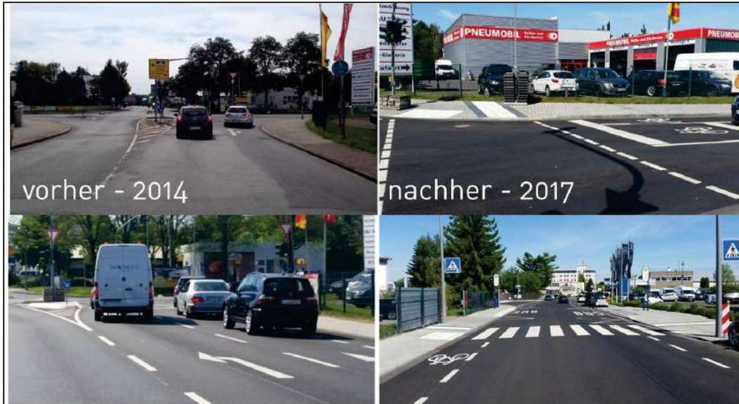
Abbildung 22: Umgestaltung Knotenpunkt K174/ Justus-von-Liebig-Straße nach Bestandsaudit – Anlass: Sanierung Fahrbahndecke und Kanalbau
