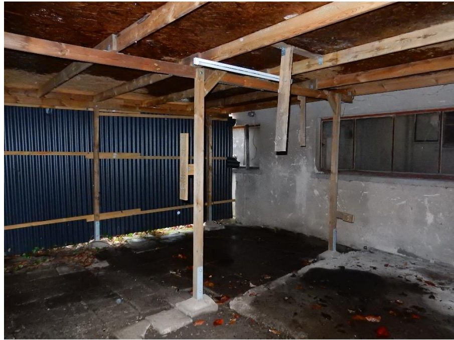
Foto 11: Der Schuppen wurde aus Holzbalken, -platten und Wellplatten provi- sorisch zusammenge- baut und bietet Nischen für gebäudebrütende Vögel.
