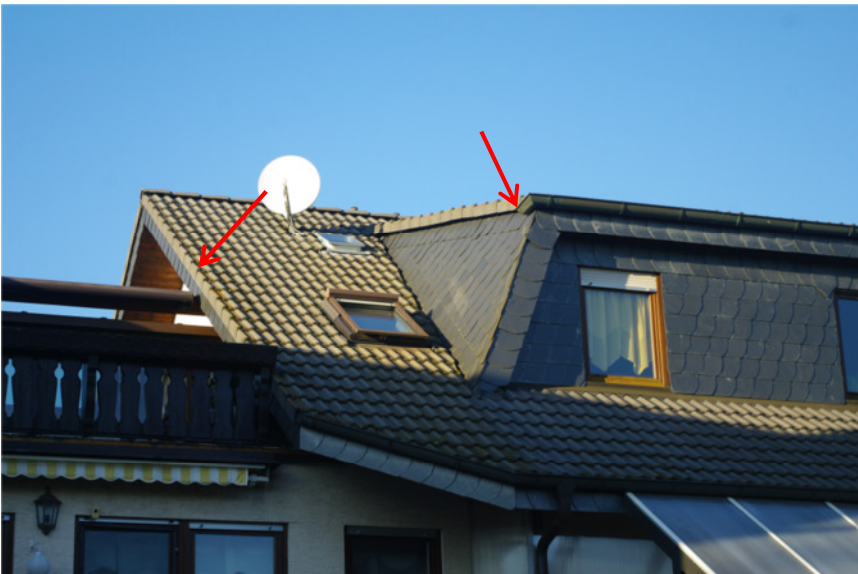
Spalten und Hohlräume an Dachziegeln und Verkleidungen als mögliche Tagesquartiere
