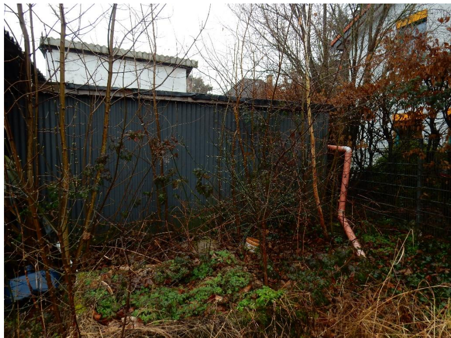
Foto 12: Blick auf die Nordseite des Schuppens mit jun- gem Sukzessionsgehölz.
