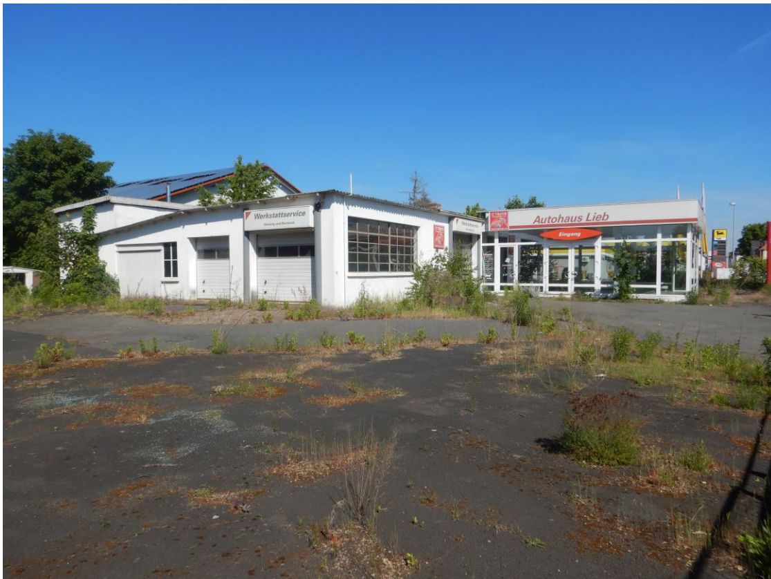
Abb. 2: Abrissgebäude und Freifläche
