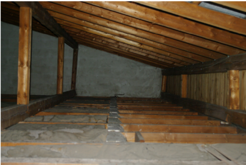
Dachboden über dem Wohnhaus
