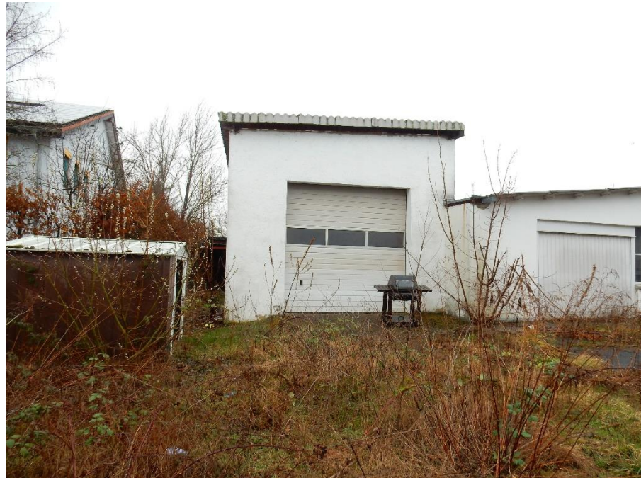
Foto 5: Im südwestlichen Untersuchungsgebiet schließen sich zwei Garagen an die Werkstatt an.
