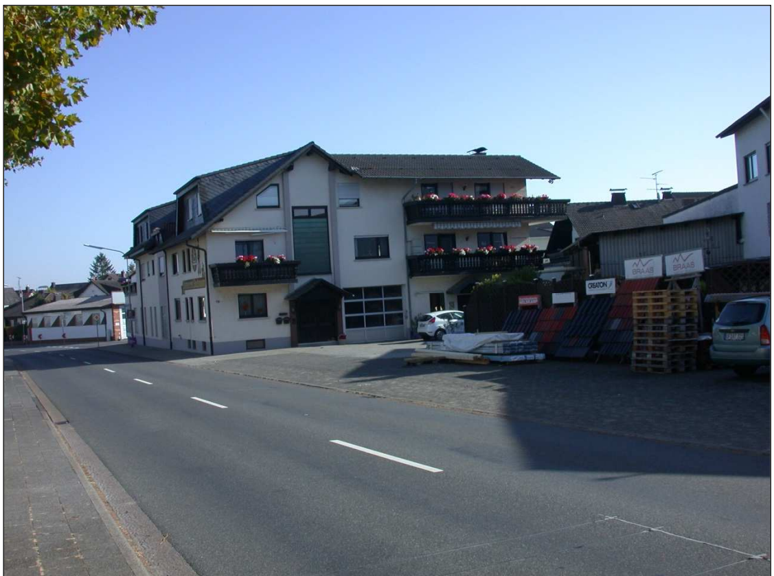
Blick von der Darmstädter Straße nach Nordosten auf die Zimmerei
