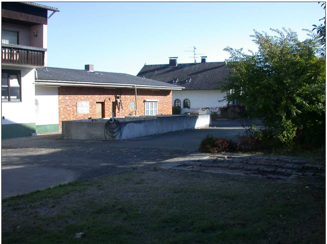
Blick auf die Kelterei mit vorgelagerten Betonbecken
