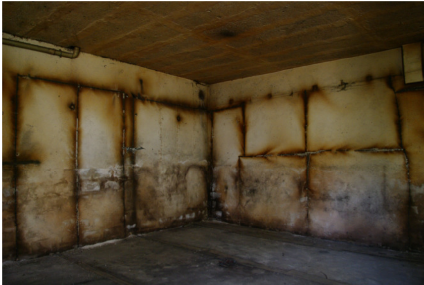
Gärkeller nach Ausräumen der Tanks
